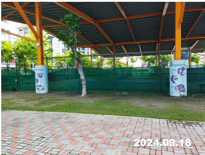
說明：施作前(整地前)
