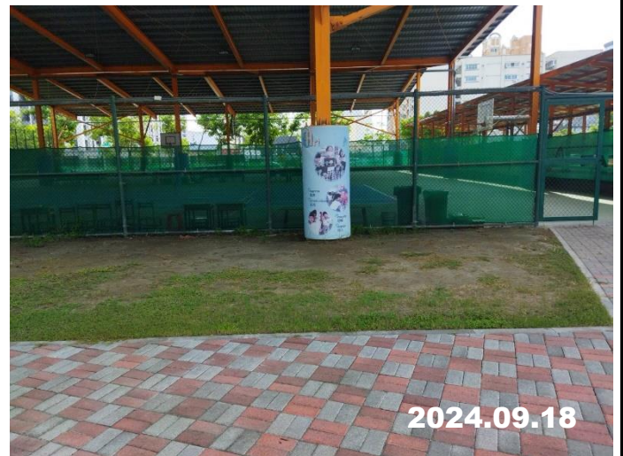
說明：施作前(整地前)
