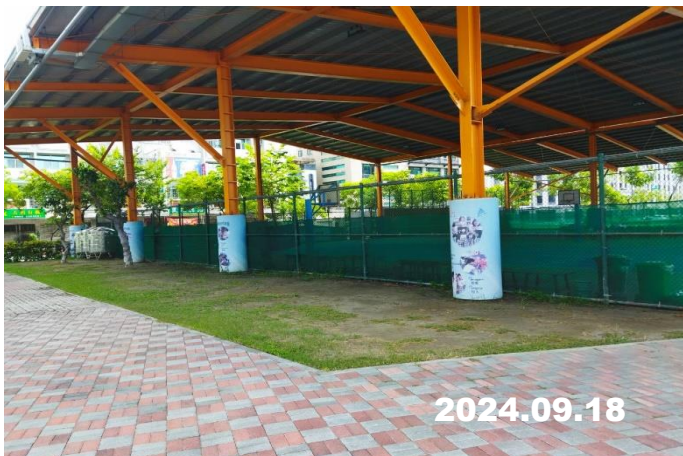
說明：施作前(整地前)
